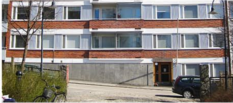
Jyväskyläläisen As Oy Minna Canthin katu 18:n putkiremontti tehtiin kokonaisvastuurakkana eli KVR:nä.
