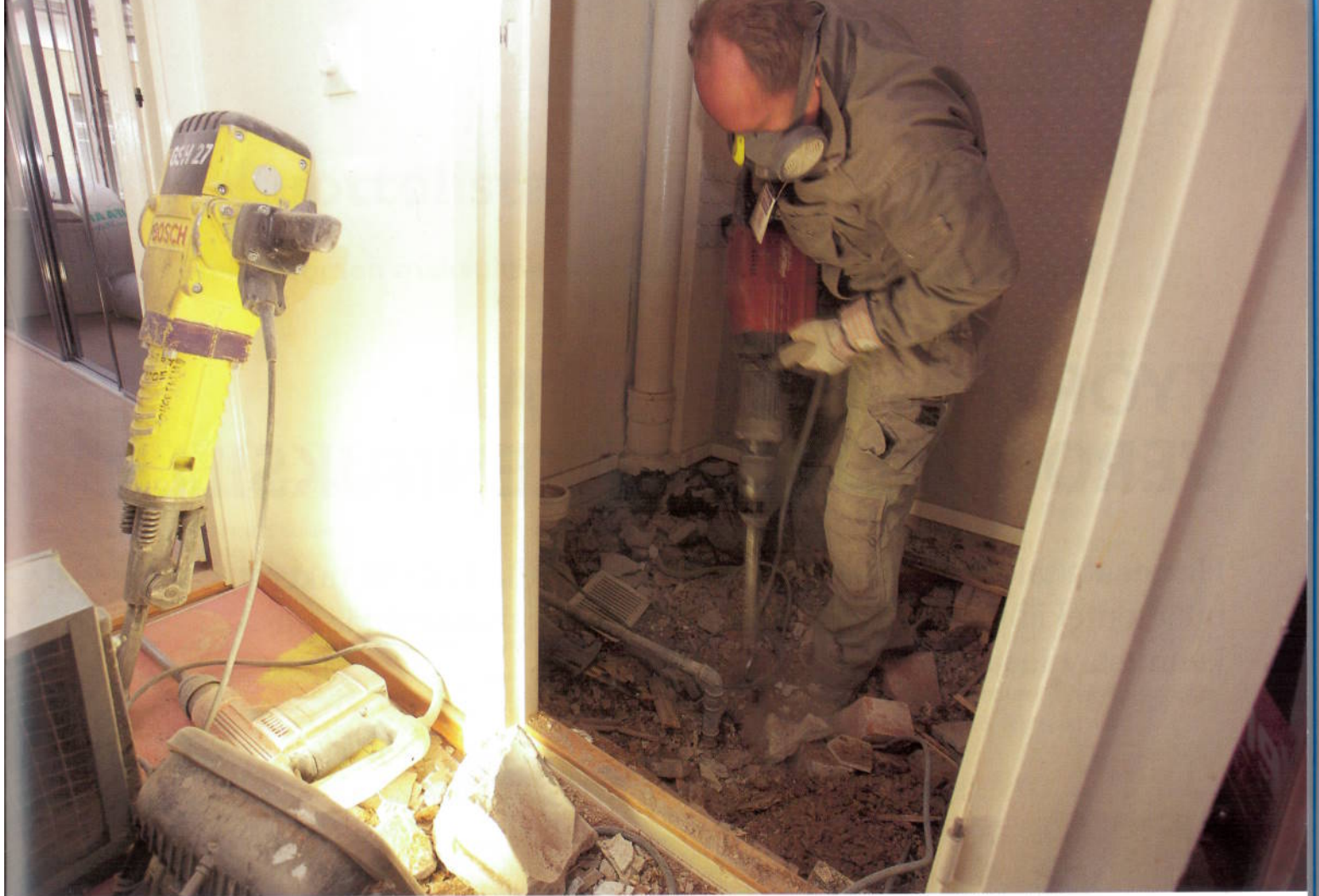
Putkiremontin yhteydessä kunnostetaan usein muutakin. Alan pääurakoitsijat ovat miltei kaikki kotimaisia.
